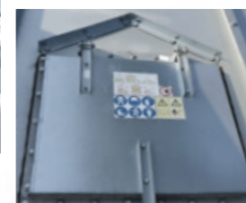
właz dachowy/kąt dachu 30 stopni
