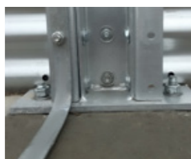
kotwy mocujące silos do podłoża
